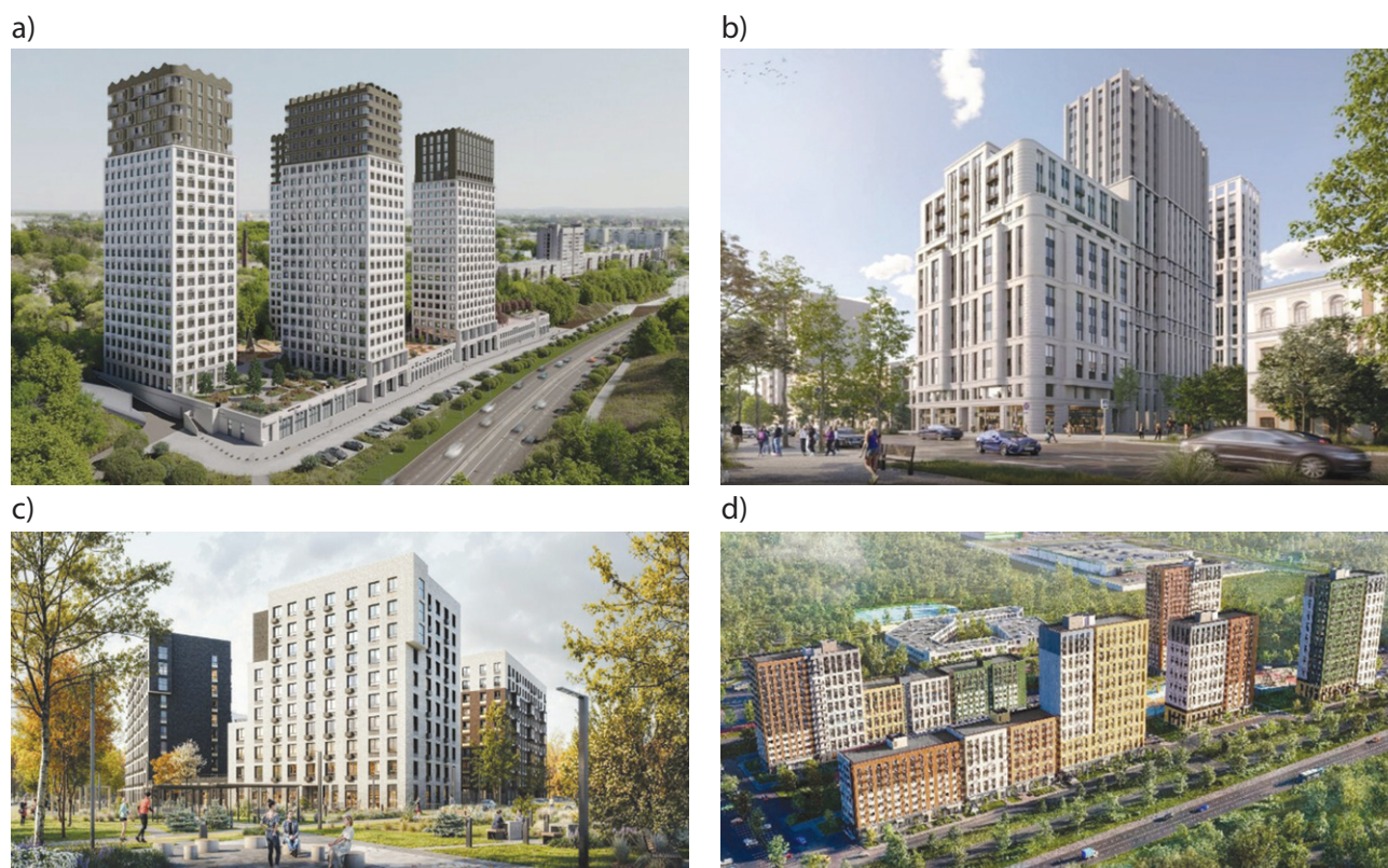
Рис. 3. Современные архитектурно-планировочные решения фасадов многоквартирных домов в жилых комплексах разных типологических групп, Хабаровск: а) ЖК «Сторис», бизнес-класс (застройщик UNIKEY); б) ЖК «Сердце Бонивура», премиум-сегмент (застройщик UNIKEY) (источник: https://unikey.space/projects/ ); в) ЖК «Северный парк», комфорт-класс (застройщик «Пик») (источник: https://clc.li/tQliC ); д) ЖК «Воронежский бульвар», эконом-класс (застройщик «Талан») (источник: https://talan.ru/khabarovsk )
