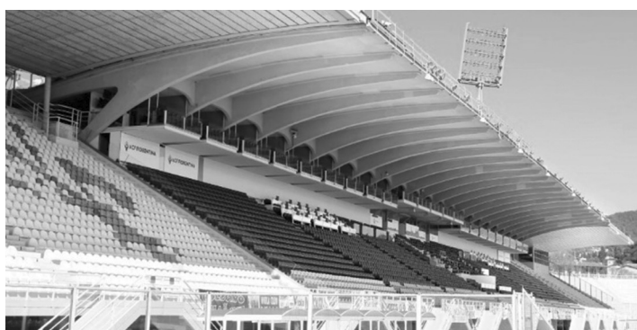
Рис. 1. Консольное покрытие стадиона во Флоренции: а) на этапе строительства 1 ; б) современное состояние 2 Fig. 1. Florence stadium cantilever roof: a) construction phase 1 ; b) present condition 2
