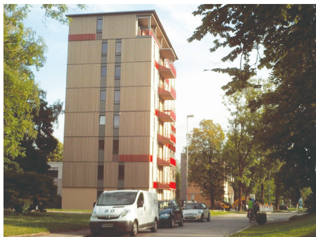
Рис. 6. Восемьэтажный деревянный жилой дом. Бад-Айблинг, Германия [12]
