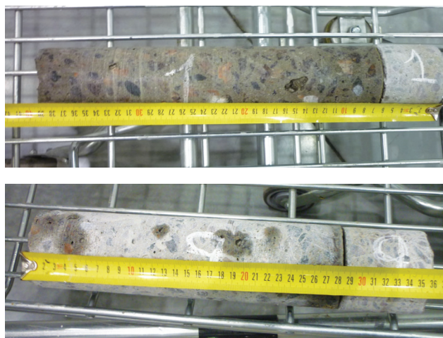
Рис. 3. Отобранные для исследования керны железобетонного основания № 1 и 9
