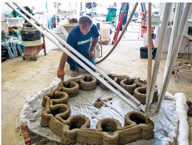
Рис. 5. Принтер с дельта-приводом Fig. 5. Delta construction printer
