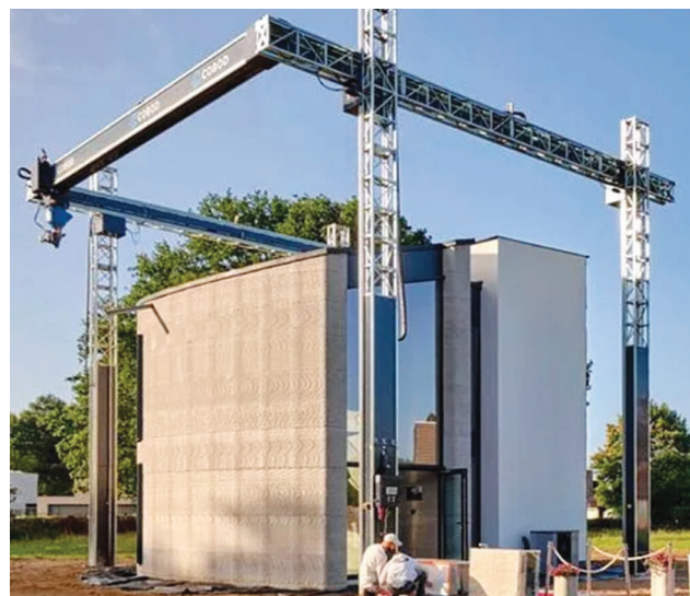
Рис. 4. Портальный строительный принтер Fig. 4. Gantry construction printer
