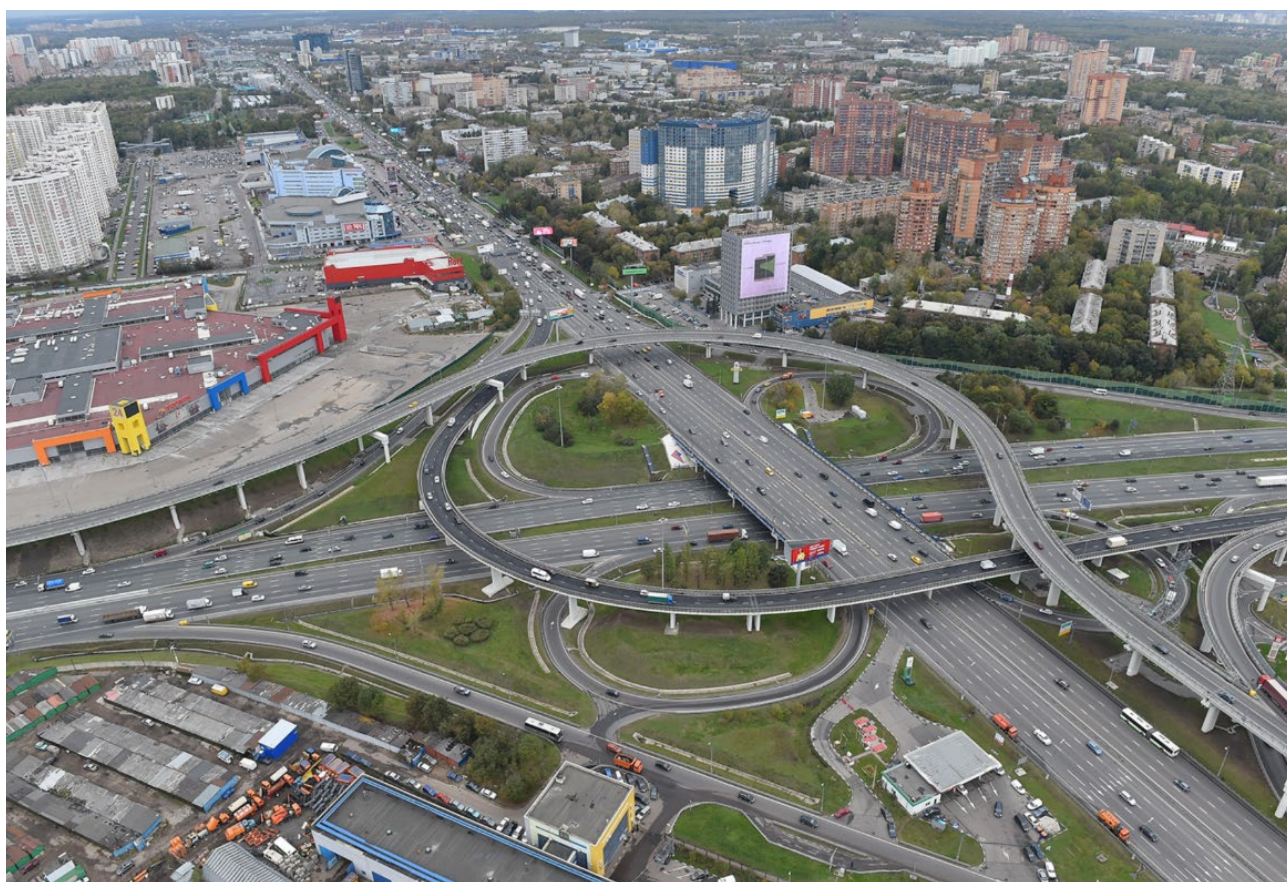
Рис. 3. Пример модификации клеверной развязки в трех уровнях. Москва, МКАД – Ленинградское шоссе
