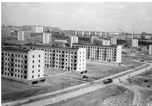
Рис. 6. Пр. Вернадского, ул. Лобачевского, ул. Коштыянца, ул. Удальцова, г. Москва [12]
