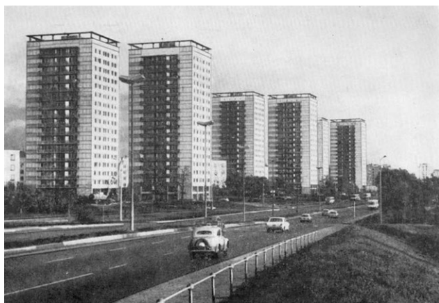
Рис. 5. Ленинградское шоссе, Фестивальная ул., г. Москва [12]
