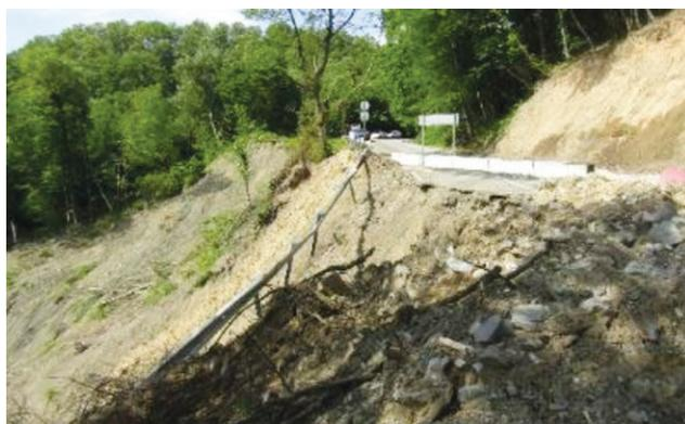
Рис. 1. Оползневая активизация с разрушением дорожного полотна отрезка автодороги 03К-453 у северной окраины с. Измайловка (фото ЮРЦ ГМСН «Гидроспецгеология»)
