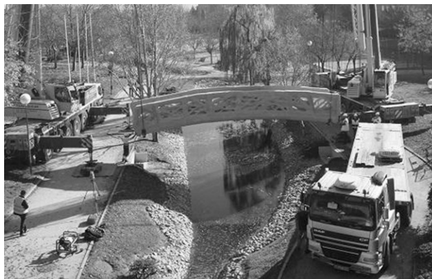
Рис. 1. Пешеходный мост в Алькобендасе (Испания), напечатанный на 3D-принтере, 2016 г. 1 Fig. 1. 3D-printed pedestrian bridge in Alcobendas (Spain), 2016 1
