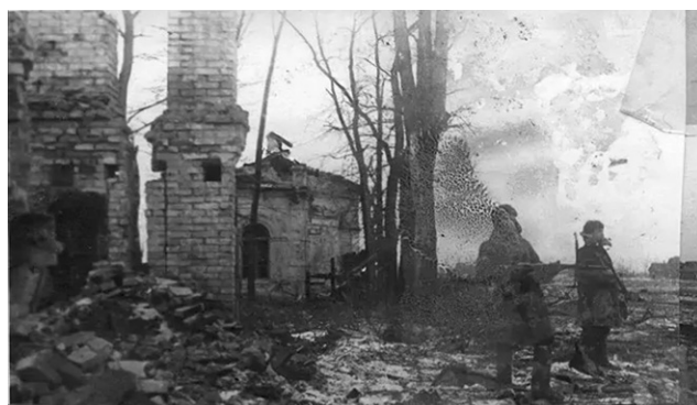
Рис. 4. Общий вид комплекса станции Александровской 27 (разрушение здания станции (северо-восточный фасад), платформы; полная утрата зеленых насаждений – примечание автора) Fig. 4. General view of Alexandrovskaya station complex 27 (destruction of the station building's northeast facade, platform; complete loss of green spaces – author's note)
