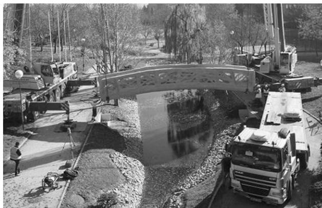
Рис. 1. Пешеходный мост в Алькобендасе (Испания), напечатанный на 3D-принтере, 2016 г.<sup>1</sup>
