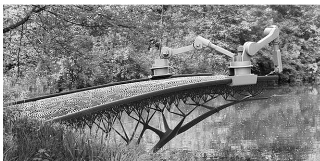
Рис. 2. Создание сварочной мостовой конструкции, Амстердам (Голландия)<sup>2</sup>
