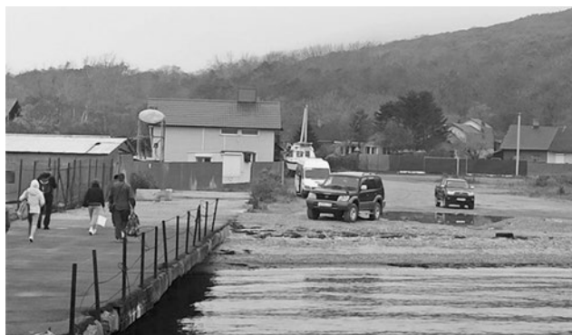
Рис. 3. Современное состояние береговой инфраструктуры полуострова Песчаного, ноябрь 2022 г. Fig. 3. Current state of coastal infrastructure of the Peschaniy Peninsula, November 2022
